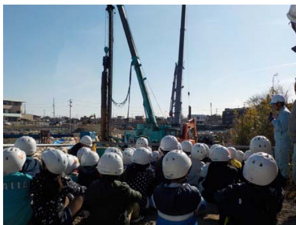
写真：杭抜き工事を見学しています。
