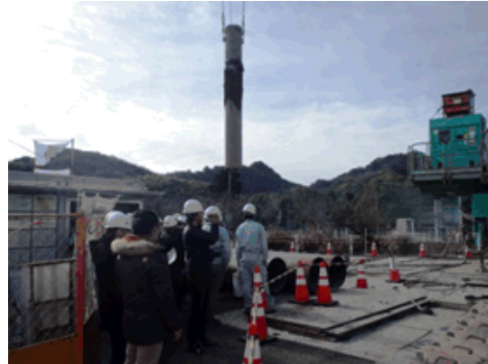
杭打ち作業中の状況
