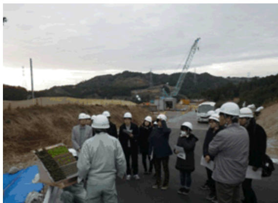
地すべり対策工事の説明
