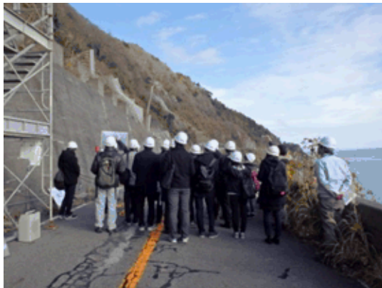
道路崩落箇所での説明
