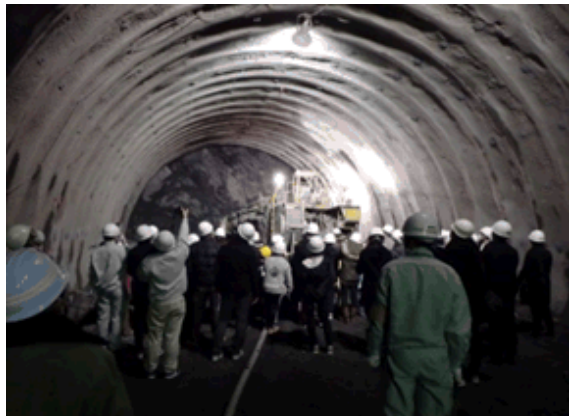
トンネルの掘削状況(親子見学会と合流)
