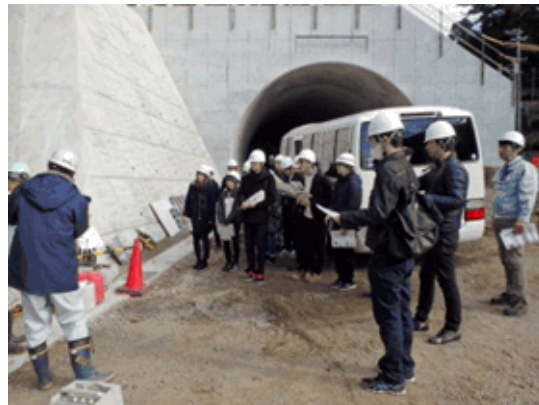
トンネル坑口での説明
