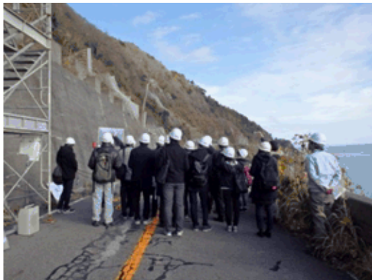
道路崩落箇所での説明
