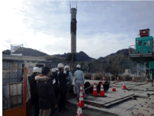
杭打ち作業中の状況
