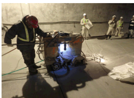
カッターにて目地施工
