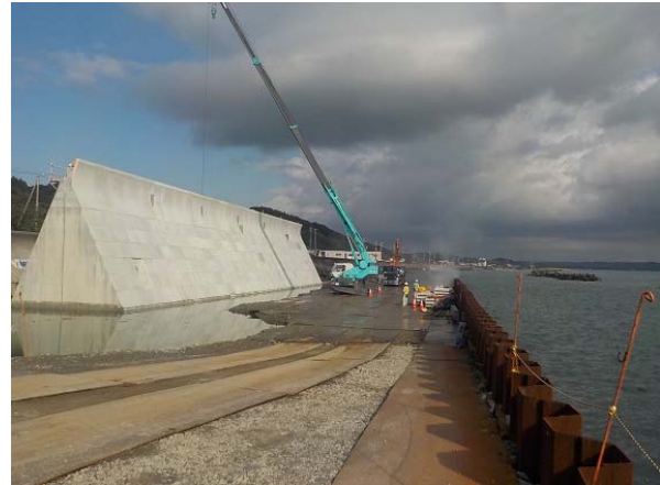
(工事の進捗状況)
