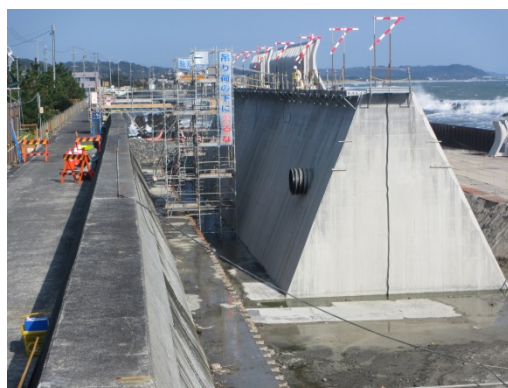
(工事の進捗状況)
