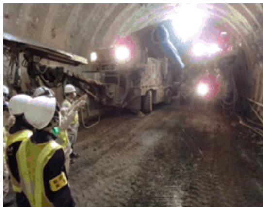
(仮称)浜当目トンネル内見学
