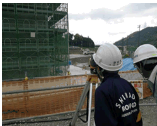
工事現場体験見学
