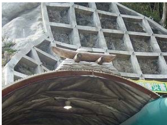
「トンネル坑口上の化粧木」
