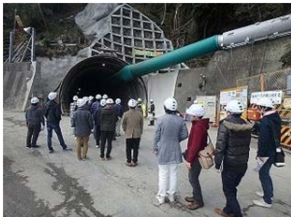
「トンネルの施工ヤードを見学する様子」
