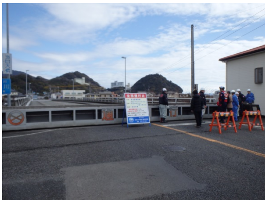
当日大橋陸閘右岸閉鎖状況
