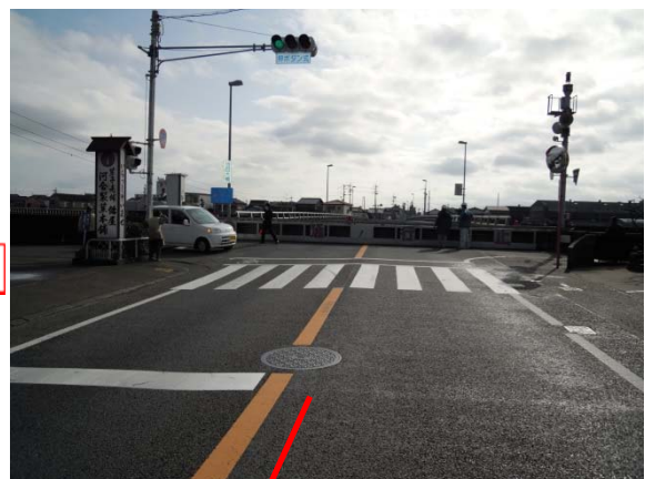
(参考) 陸閘の閉鎖状況
