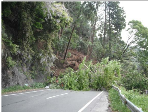
斜面崩落直後
