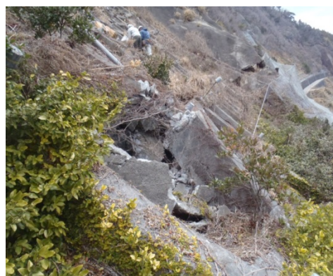
(道路上の斜面状況)
