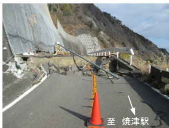
← 静岡市側の沈下状況 (1月7日)
