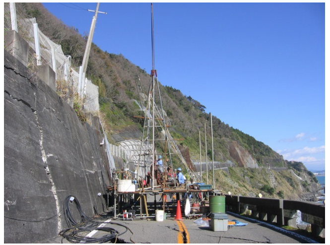
地すべり内でのボーリング調査 （11月5日～12月中旬を予定）
