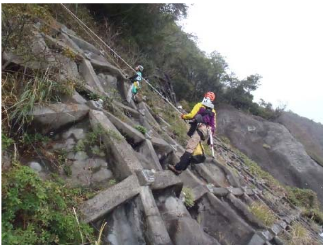
ロッククライミングによる斜面調査 （11月7日実施）
