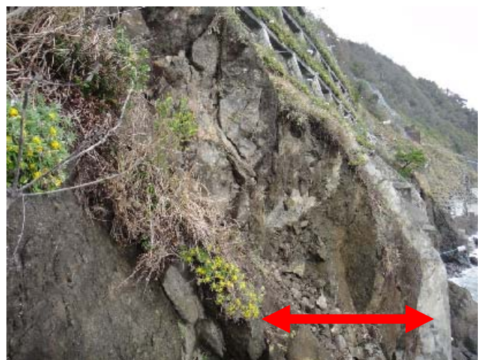
地すべりにより 海面付近斜面が押出されています （11月7日撮影）
