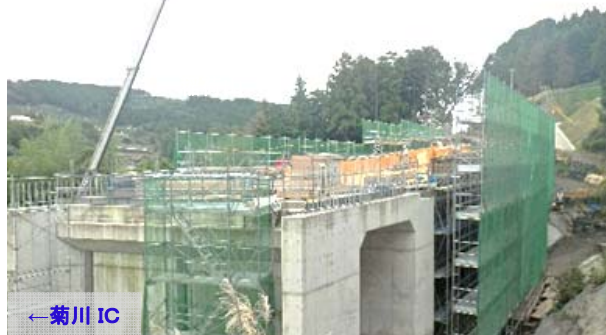
《おがみ橋(1号橋)付近》
