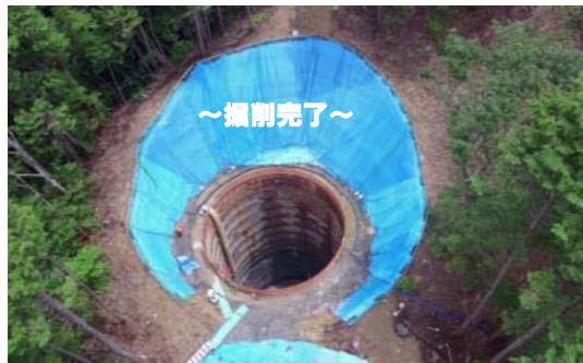
《3号橋P5橋脚_柱状体深礎基礎φ11m L=21m》
