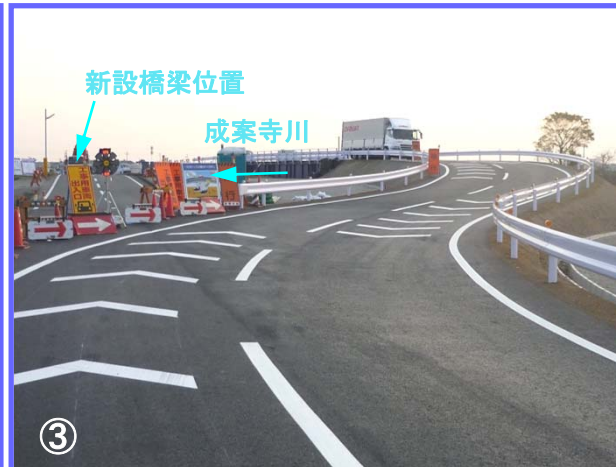
成案寺川に架かる新設橋梁工事のための迂回路が完成しました。これから橋台（橋桁を載せる基礎）工事を行っていきます。
