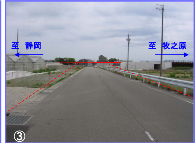
今年度より栃山川左岸の市道横須賀上小田線交差点の工事に着手します。(5月8日撮影)
