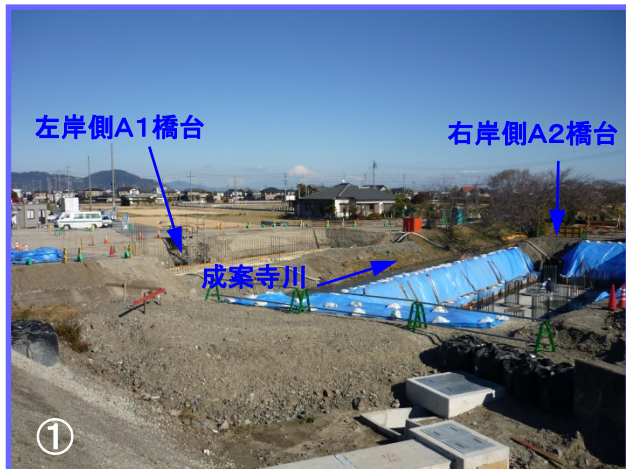
成案寺川に架かる新設橋梁の橋台工事が順調に進んでいます。来年春には橋台工事が完了します。
