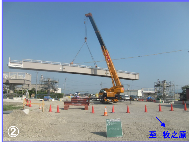
② 惣右衛門地区で施工中の横断歩道橋では、橋長約32m、総重量約60トンの鋼製桁を架設しました。(8月29日撮影)
