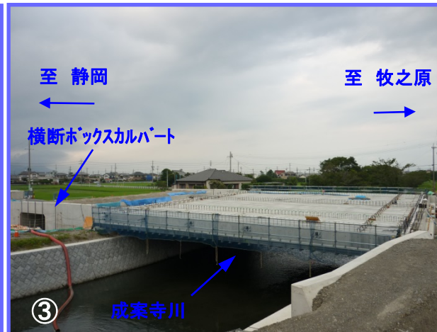
成案寺川に架かる新設橋梁の桁架設が完了し、左岸側では、国道の下を横断するボックスカルバートの施工が完了しました。
