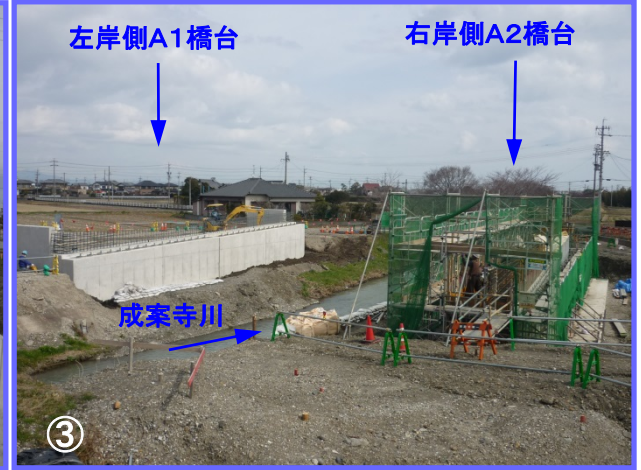
③ 成案寺川に架かる新設橋梁の橋台工事のうち、左岸側では橋台上部のコンクリート打設が完了しました。右岸側も引き続きコンクリート打設します。
