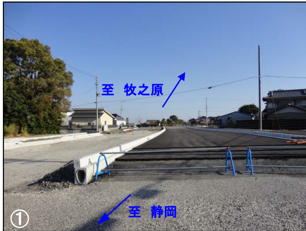
三和交差点南側の舗装工事を実施します。 (3月27日撮影)
