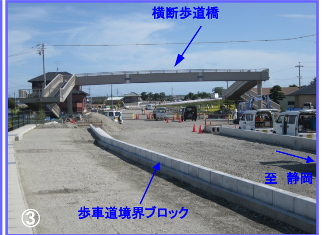
③ 惣右衛門地区の横断歩道橋の桁架設が完了し、その周辺では、歩車道境界ブロックなど施工を行っています。(9月5日撮影)
