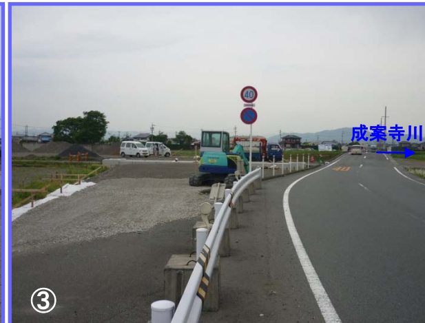
③ 今年度施工予定の成案寺川に架かる橋梁工事のために迂回路を造っています。今年の秋には迂回路が完成します。
