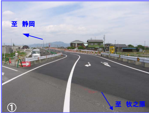
惣右衛門地区で橋梁工事のため1年半にわたり、仮設橋での通行をしていましたが、橋梁工事も完成し3月28日に開通しました。(5月12日撮影)
