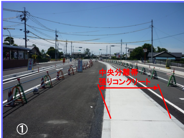
中央分離帯の施工が完了しました。今後の維持管理を考慮し、ブロック間にコンクリートを張りました。この後残り2層の舗装工事を行います。
