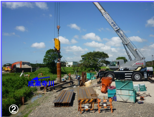
成案寺川に架かる橋梁工事のために迂回路の仮橋の基礎工事を行っています。秋には迂回路が完成します。
