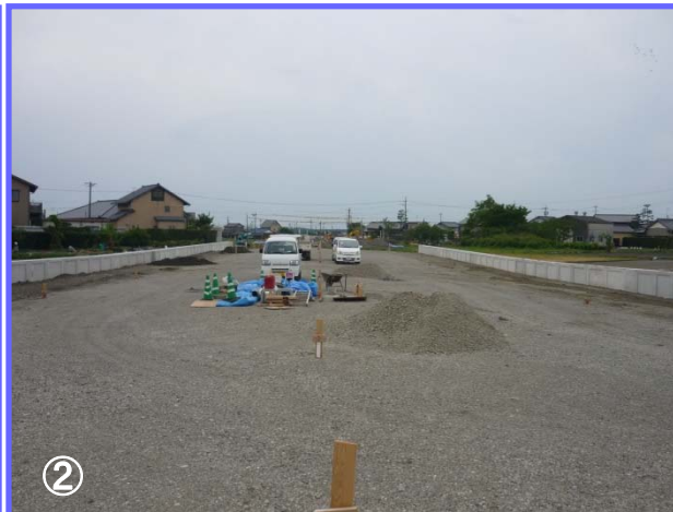
② 前年度から継続している道路新設工事の施工状況です。道路外側に側溝を設置し、田んぼの土を良質な材料に置き換えを行っています。
