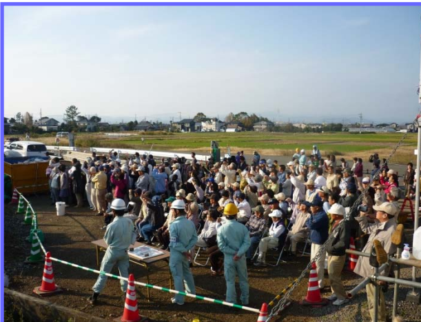
栃山川に架かる橋梁工事において施工業者主催で地元地域の方を対象に現場見学会を行いました。合計約240名の方が参加されました。
