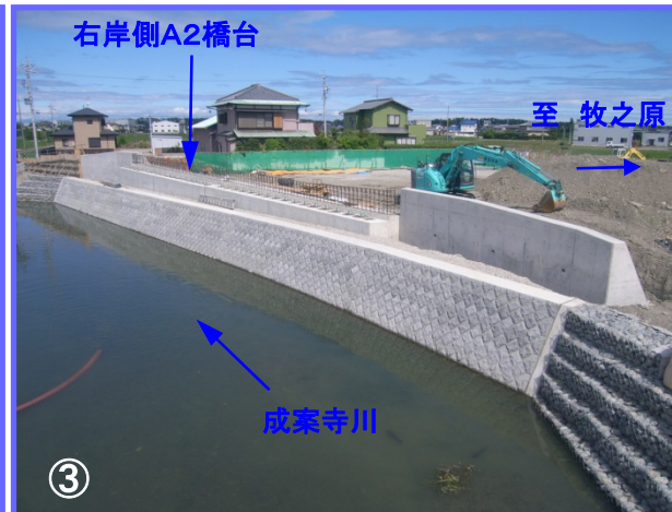
成案寺川に架かる新設橋梁の右岸側では、橋台前面の護岸工事が完了し、河川堤防のコンクリート擁壁の施工を行っています。
