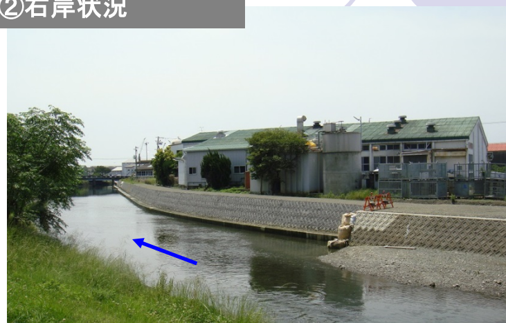
②右岸状況
