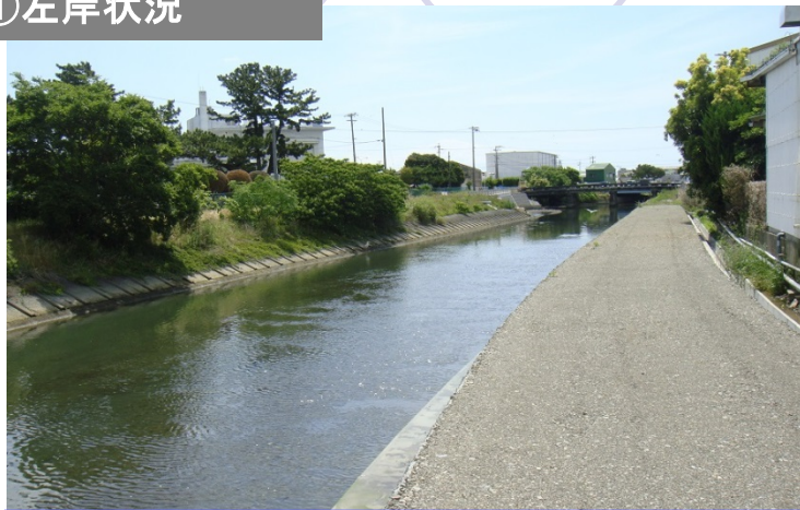
①左岸状況
