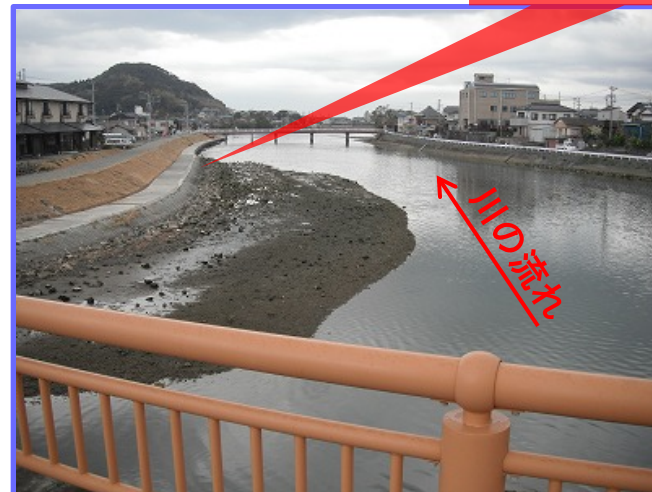
事業を行った区間(港橋から下流側)
