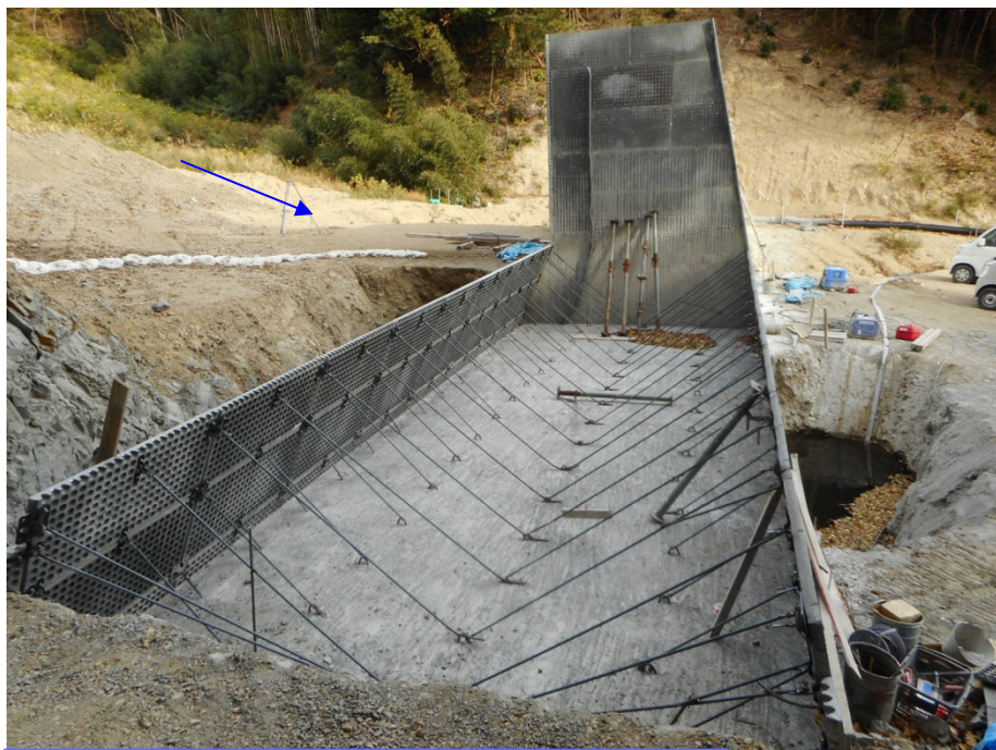
残存型枠設置中の様子
