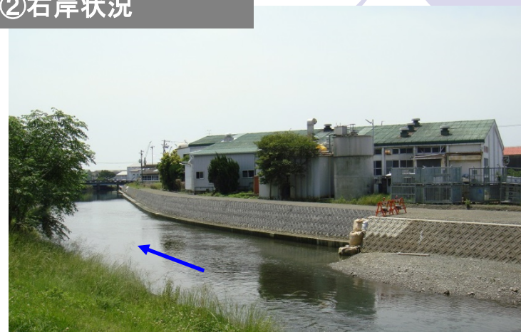
②右岸状況
