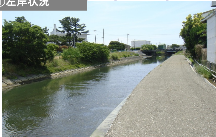
①左岸状況
