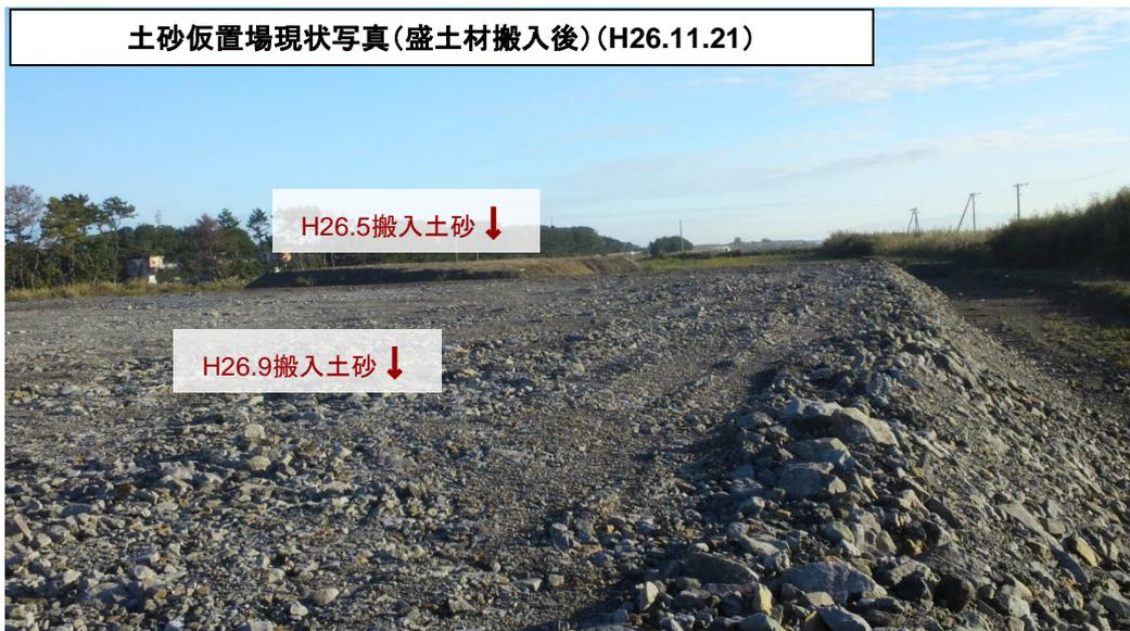
「命山」を整備するために、吉田漁港内に設置した仮置場に良質土砂をストックしました。約12,600m<sup>3</sup>の土砂を搬入し、質土の確保に努めました。
