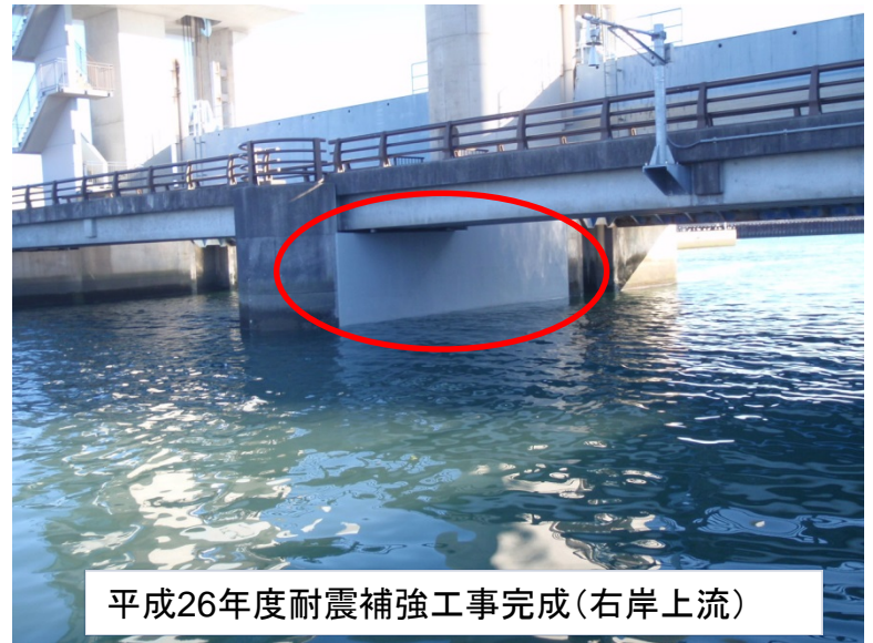
平成26年度耐震補強工事施工状況(右岸上流)
