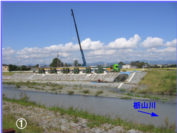
10月中旬から11月中旬にかけて、栢山川に橋桁を架設するため、現在準備を行っています。
