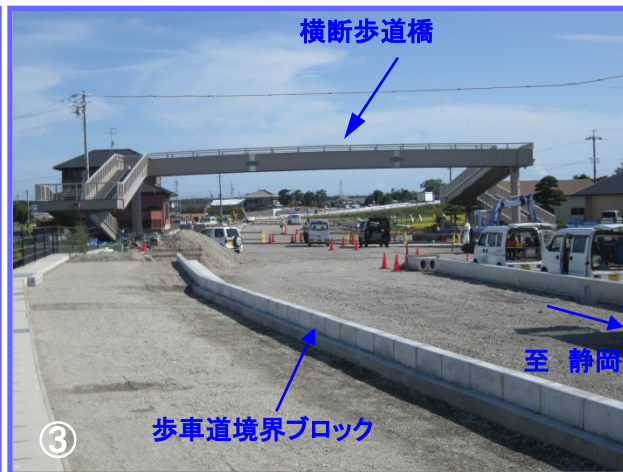
惣右衛門地区の横断歩道橋の桁架設が完了し、その周辺では、歩車道境界ブロックなど施工を行っています。(9月5日撮影)
