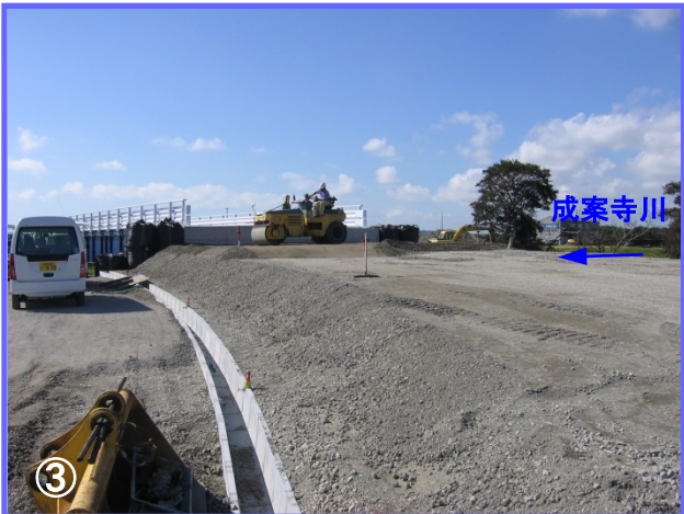
成案寺川に架かる橋梁工事のために迂回路を造っています。仮橋の架設が終わり、橋梁前後の造成を行っています。
