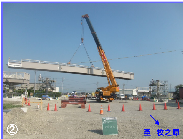
惣右衛門地区で施工中の横断歩道橋では、橋長約32m、総重量約60トンの鋼製桁を架設しました。(8月29日撮影)
