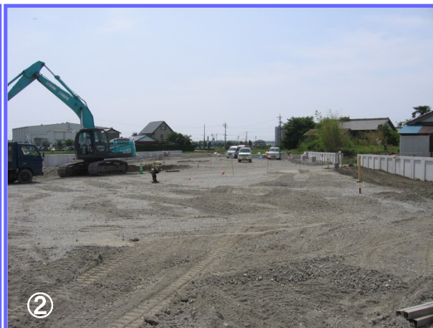
前年度から継続している道路新設工事の施工状況です。道路外側に側溝を設置し、田んぼの土を良質な材料に置き換えを行っています。
