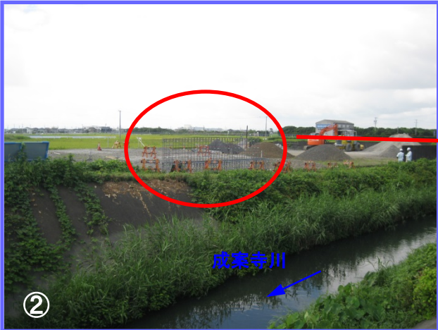
成案寺川に架かる橋梁工事のために迂回路の仮橋の橋台工を行っています。秋には迂回路が完成します。
