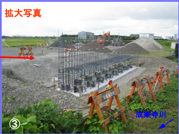
成案寺川に架かる橋梁工事のために迂回路の仮橋の橋台工を行っています。コンクリート打設後、橋桁を架設します。
