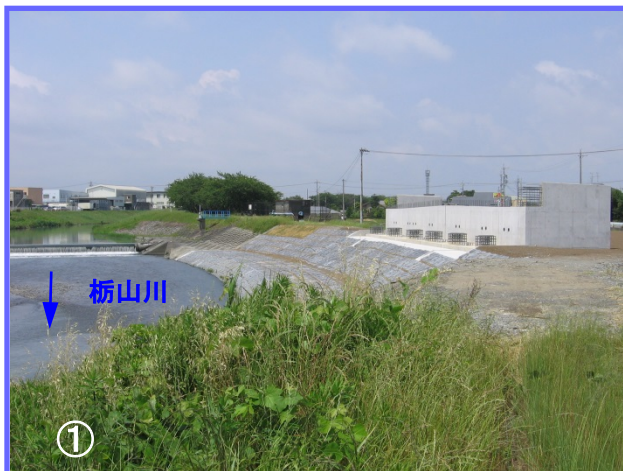
栴山川の静岡側の橋台(橋を載せる基礎)が完成しました。今年の秋から橋桁を架設します。
