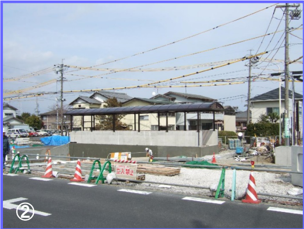
② 下り線の地下横断歩道の施工状況です。地下水の漏水対策としてコンクリートの周りに防水シートを巻いてモルタルで固めます。
