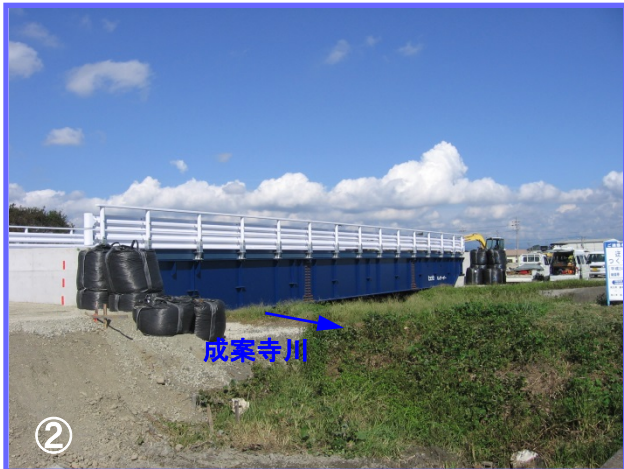
成案寺川に架かる橋梁工事のために迂回路を造っています。仮橋の架設が終わり、今月末ごろ迂回路が完成します。
