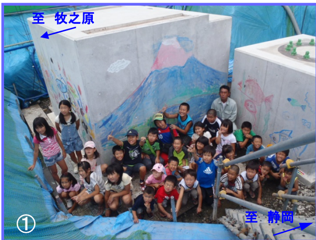
惣右衛門地区で施工中の横断歩道橋の基礎コンクリートに、地元の子供たちが記念に富士山など絵を書き入れました。(7月21日撮影)
