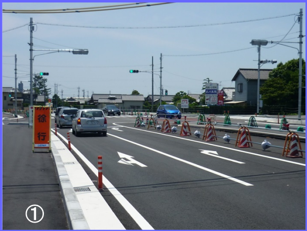
6月15日に交通切替えを行い、交差点に信号機が点灯しました。下り線(牧之原方面)と上り線(静岡方面)の車両通行を分離しました。
