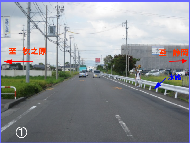
バイパス本線及び市道取合工事を今年度行います。水路付け替えや市道の造成・舗装工事を行っています。
