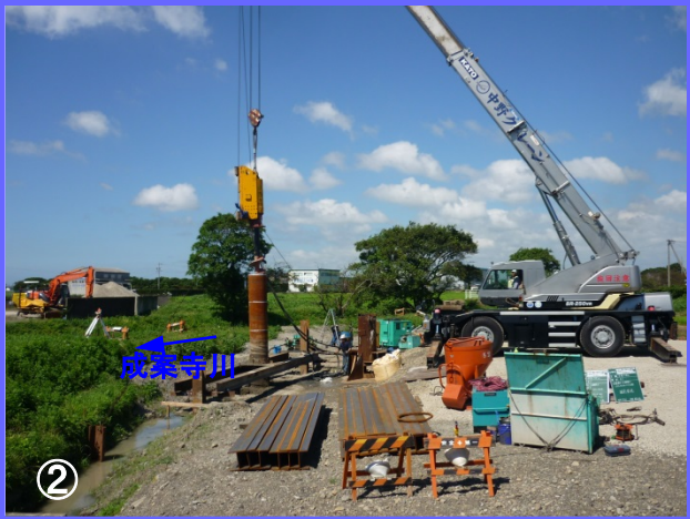
成案寺川に架かる橋梁工事のために迂回路の仮橋の基礎工事を行っています。秋には迂回路が完成します。
