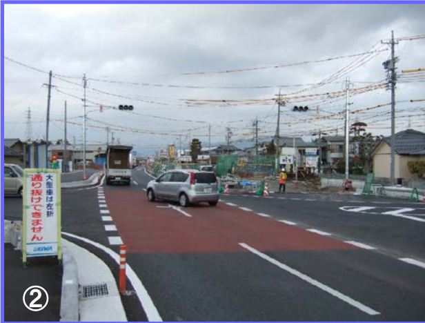
② 付替交差点に赤いカラー舗装を施工しました。 6月1日に信号機が稼動しますが、それまでの間の安全対策の一環です。
