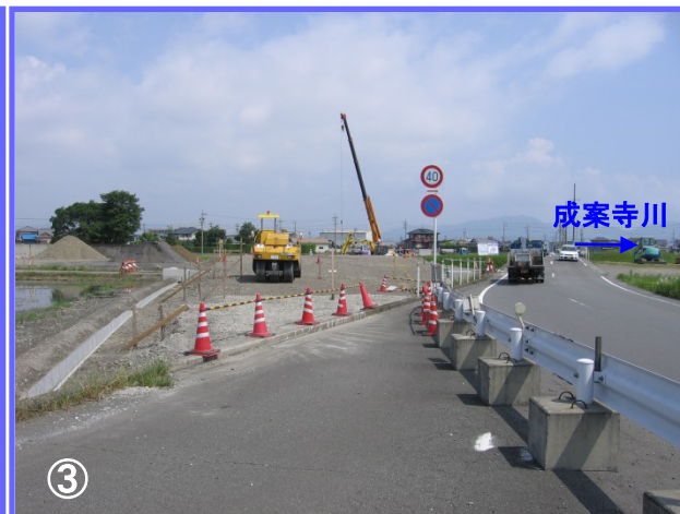
今年度施工予定の成案寺川に架かる橋梁工事のために迂回路を造っています。今年の秋には迂回路が完成します。
