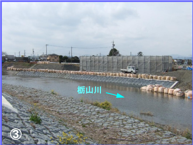
③ 栢山川の橋台工の施工状況です(静岡側)。防塵ネットの中で、鉄筋、型枠を設置して、コンクリートを打つ準備を進めています。
