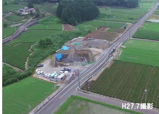
3号橋P3橋脚施工状況
