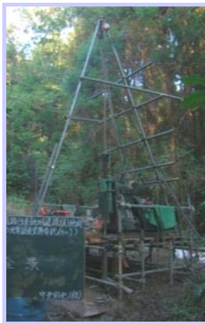
地質調査の状況 (神谷城地区)
