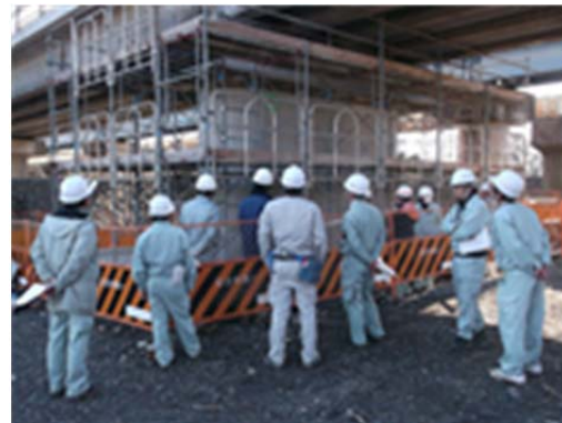
橋梁耐震補強工事現場にて(OJT研修)
