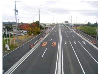
供用した4車線道路
