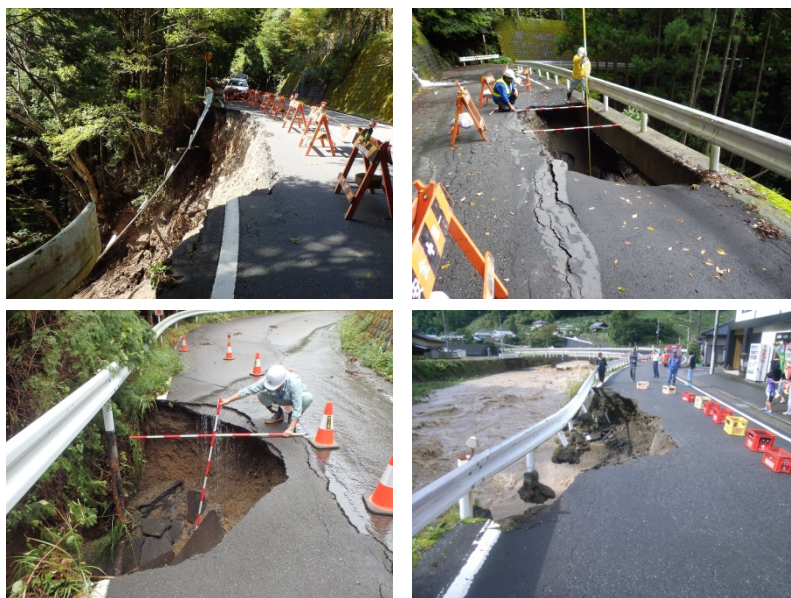
台風18号による道路の被災
