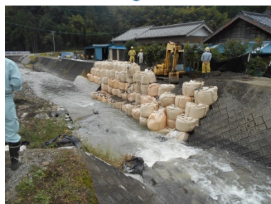
応急対策実施状況
