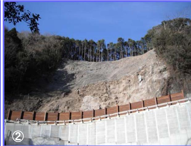
高さ約5mの仮設防護柵を42m設置しました。この上にベニヤ板を取付けて小石等の飛散に備えます。
