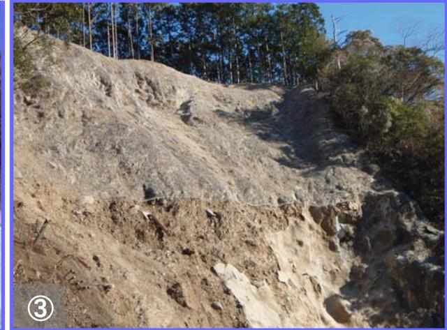
落石対策として、斜面上部に金網ネットを張り付けました。
