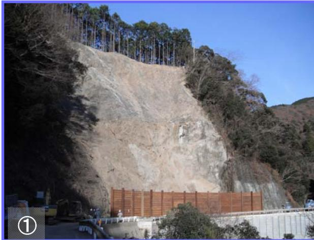
斜面の応急対策や仮設防護柵の設置作業が概ね完了しました。
