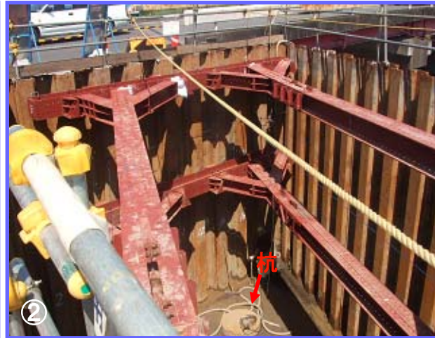
現道西側では、杭の設置が完了しました。これから橋台を施工していきます。
