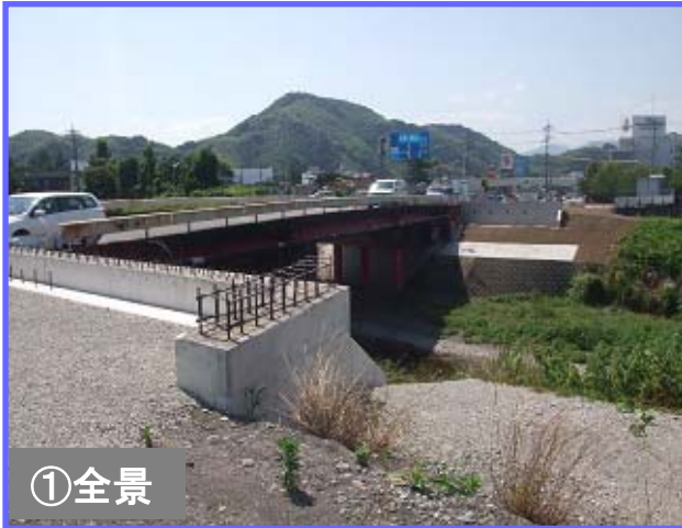
葉梨川の広幅橋です。今月、現道東側の橋台（橋をのせる基礎）が完成しました。
