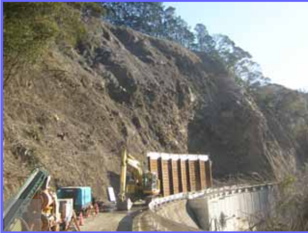
不安定土塊と崩土の除去作業が概ね完了し、今後仮設防護柵の復旧及び増設を行います。
