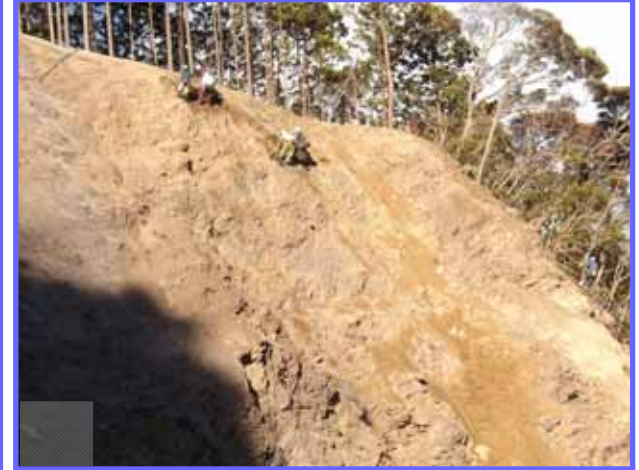
人力により尾根付近に残っている不安定な土塊の除去作業を行っています。
