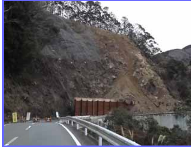
来週から斜面の応急対策と崩土の除去作業を開始します。
