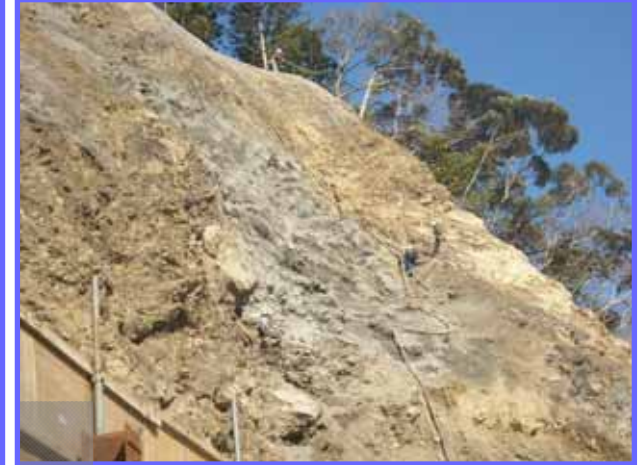
亀裂の多い岩盤箇所には応急的にモルタルを吹付け、地盤を強化しています。
