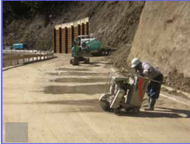
仮設の防護柵を設置するための準備を行っています。
