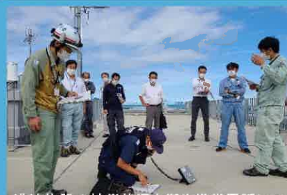
港湾施設の被災状況を衛生携帯電話にて通信訓練している様子(9月21日)
