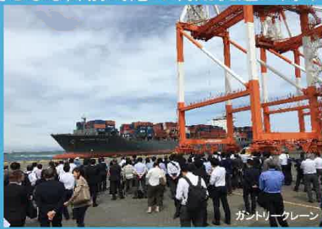
ガントリークレーン
