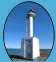
防波堤B灯台
