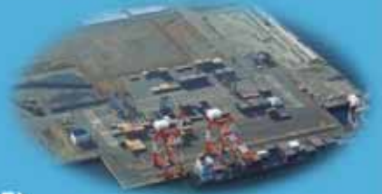
御前崎港コンテナターミナル
