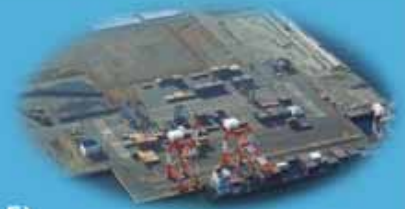
御前崎港コンテナターミナル
