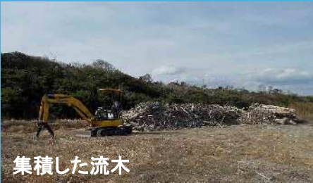
清掃作業の様子
