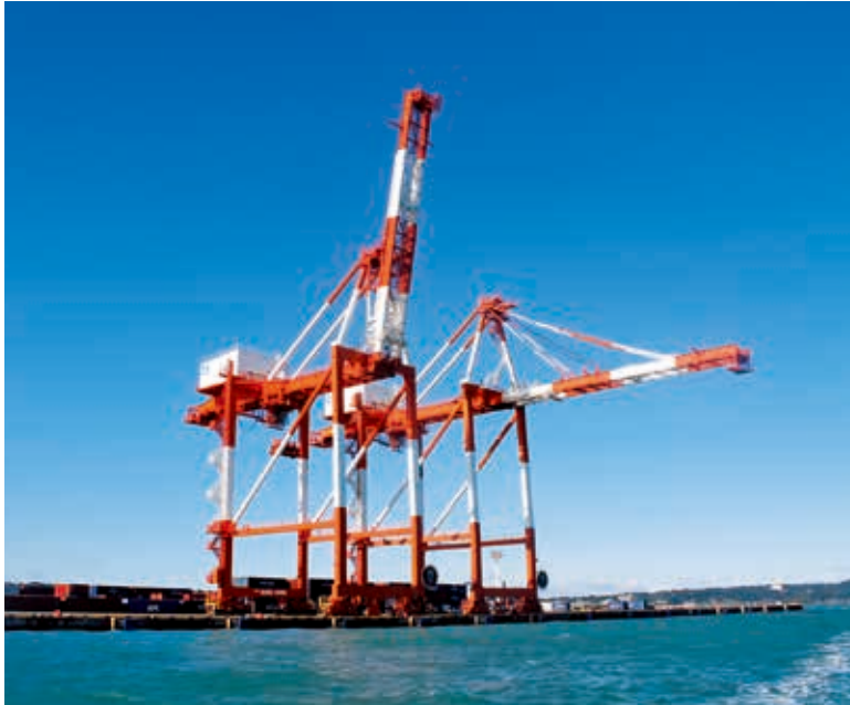
西埠頭ガントリークレーン
