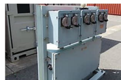
リーファークンテナコンセント設備 Reefer Container Outlet Equipment
