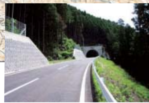
寺の沢橋から西亀久保トンネル
