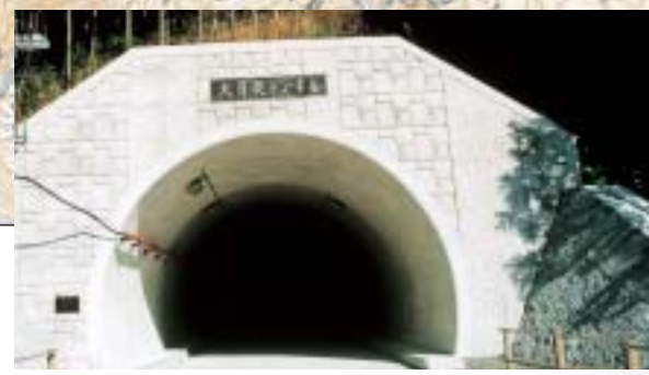
大月夜トンネル
