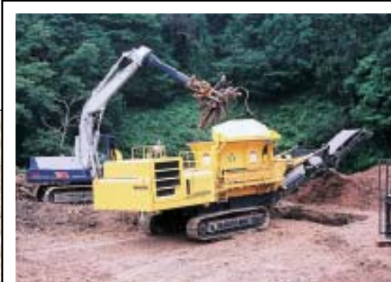
木材のチップ化 道路工事に伴い発生した根株をチップ化し、再利用を図ります。
