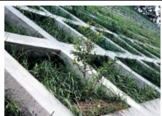
郷土種の植栽 環境に配慮し道路の法面に郷土種を植栽します。
