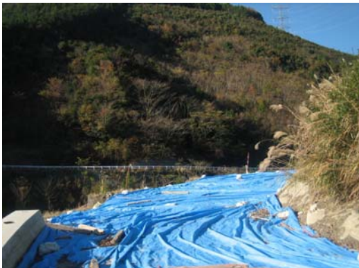
起点側からの写真
