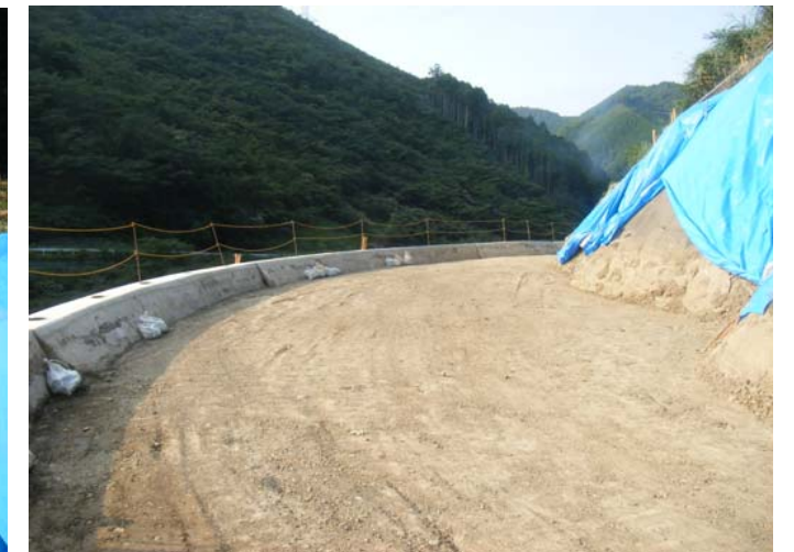
荷重を軽減するための道路盛土の除去が完了しました。(8月18日)
