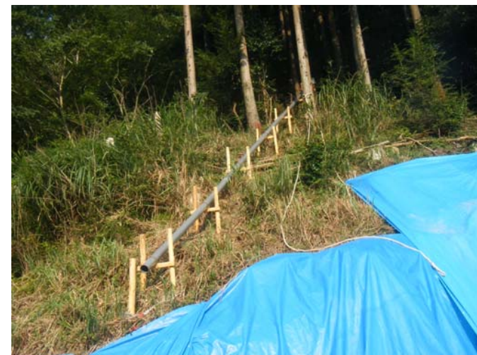
法面の動きを監視するため、伸縮計による観測をしています。(8月11日～)
