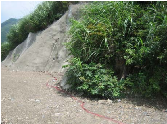
路面の状況①
