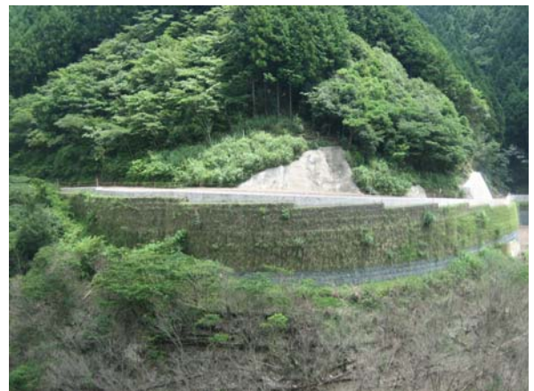
調査箇所全景
