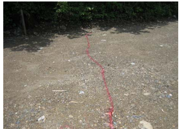
路面の状況②
