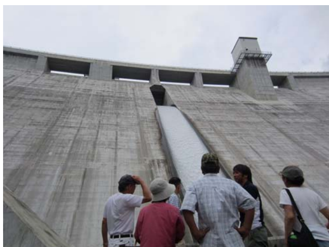
ダムを見上げて
