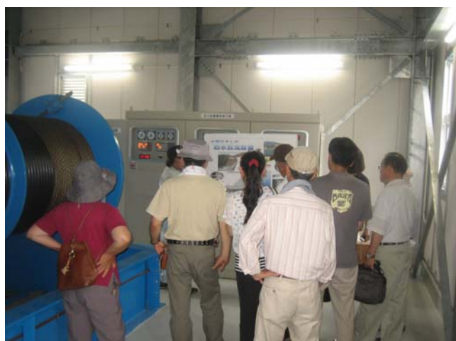
ダムの設備(写真:取水設備)も説明
