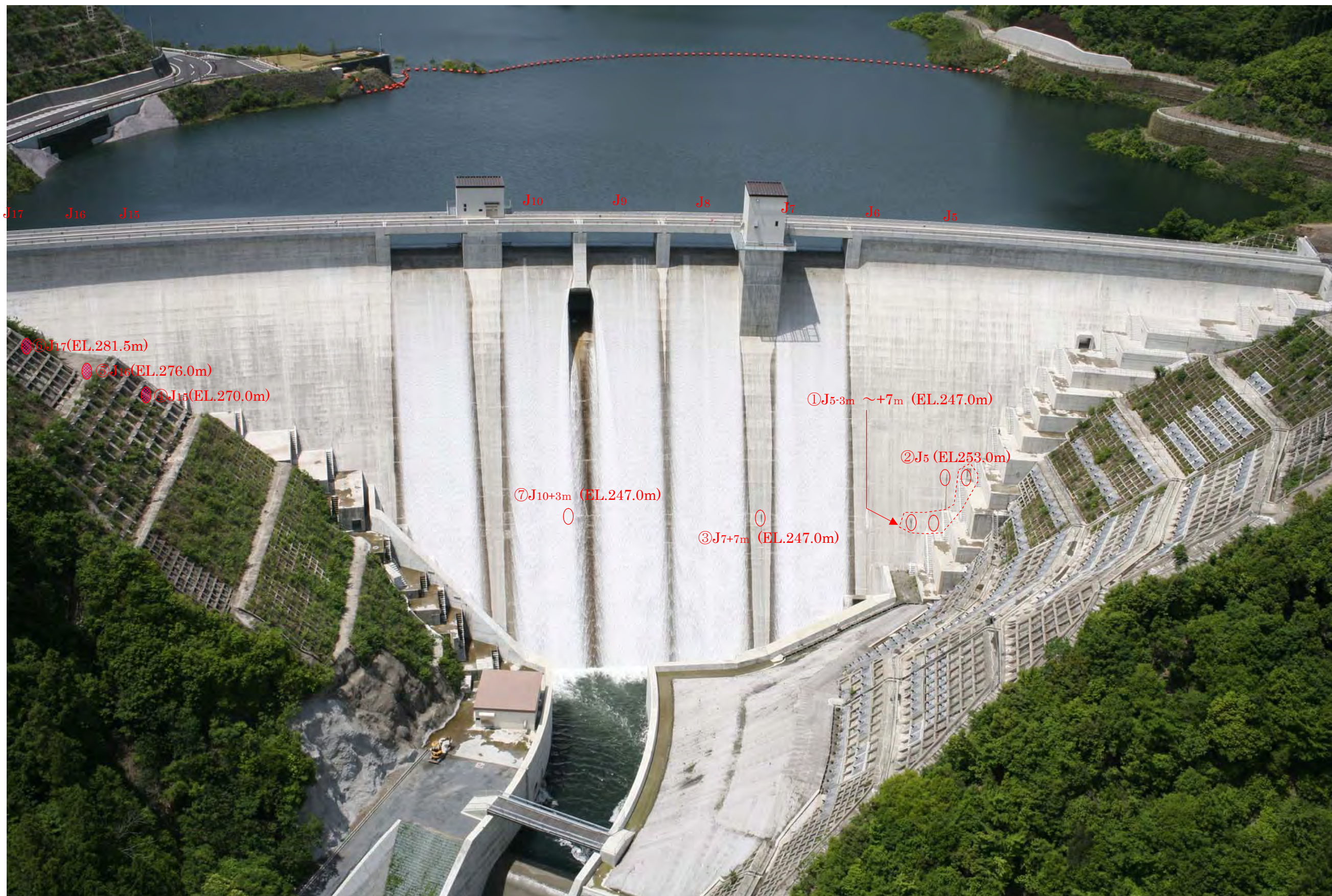
写真 2.1.1 堤体下流面のしみ出し (全景 SWL. 5/18)
