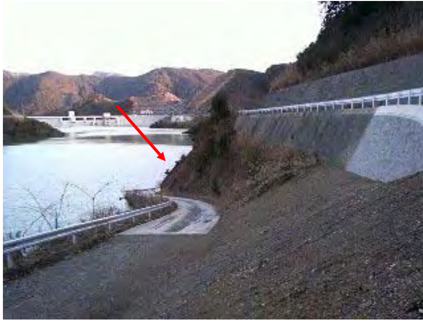
写真 2.2.13 工事用道路から崩壊地方向を望む。
