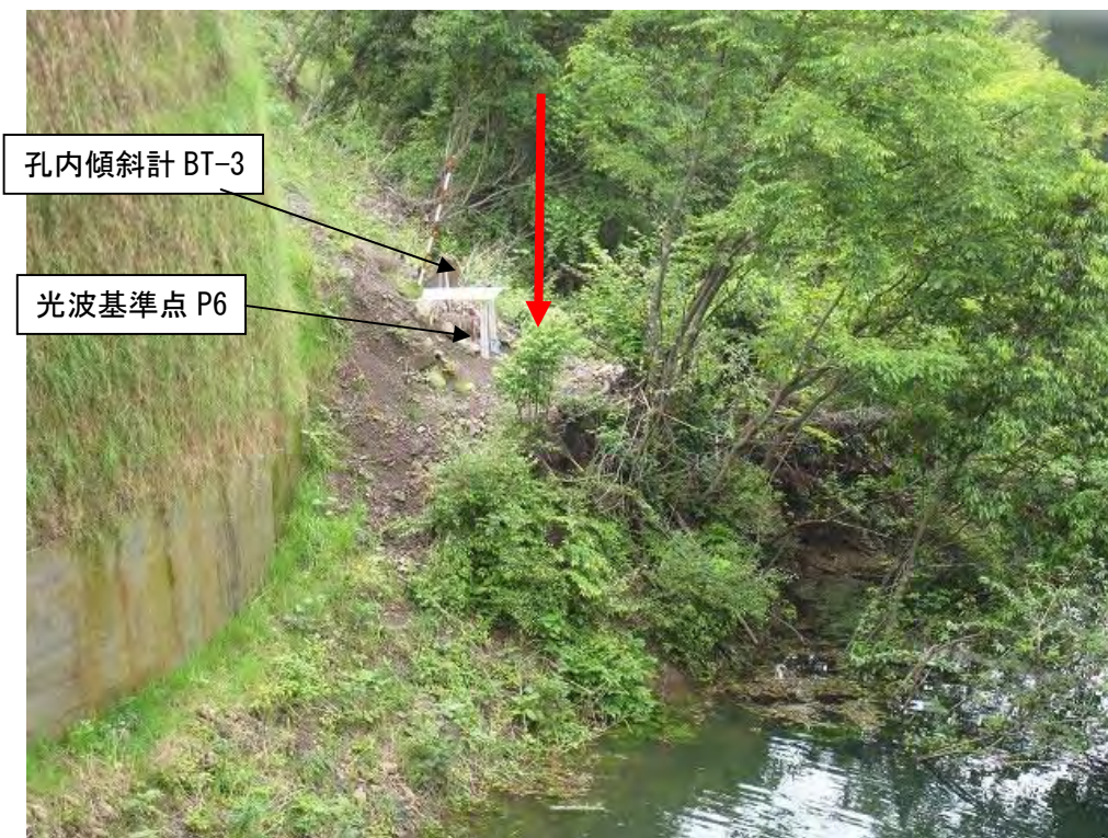
写真 2.2.10 亀裂近景（上流から下流方向を望む 5/8：貯水位 281.67m）
