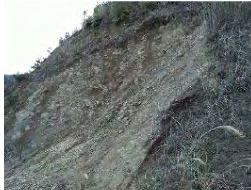
写真 2.2.14 崩壊地の状況。強風化岩盤（土砂化している）が分布。
