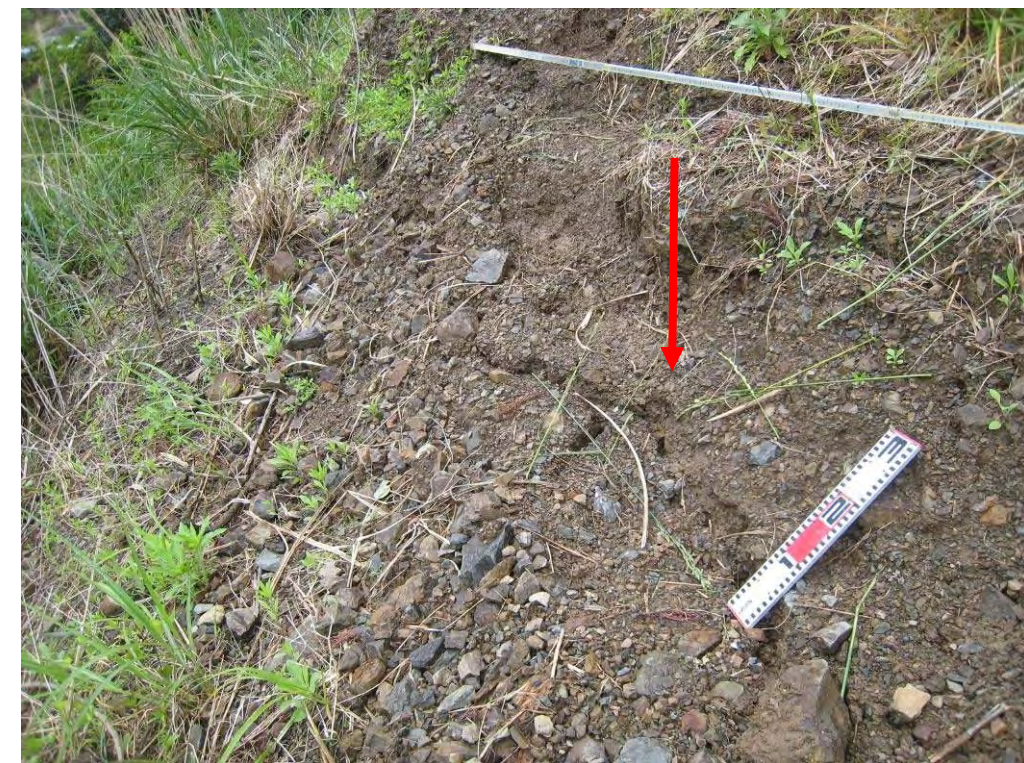
写真 2.2.8 亀裂近景（開口幅は最大で5cm程度）
