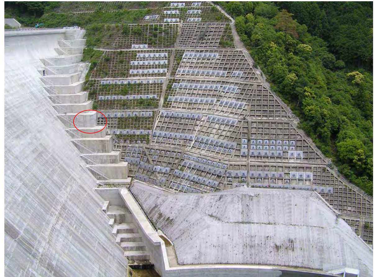
堤体下流左岸全景 (赤丸が対象フーチング位置)
