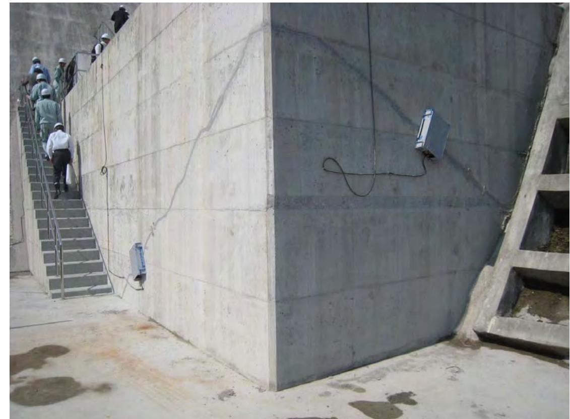
EL260m フーチングひび割れ
