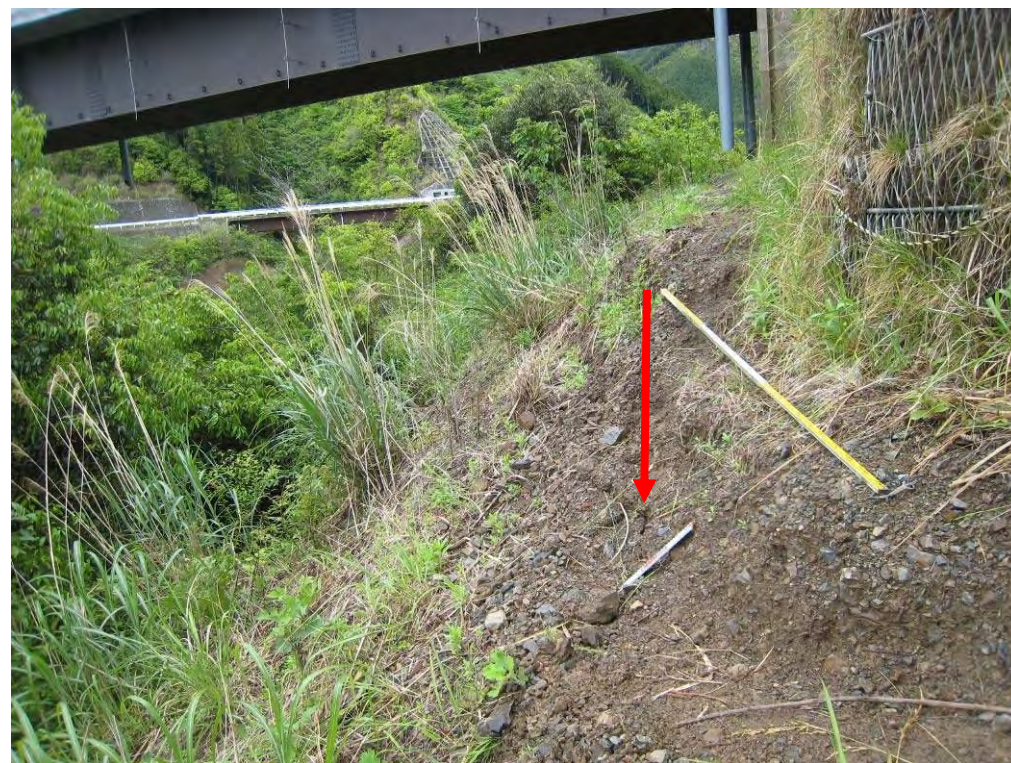
写真 2.2.7 亀裂近景（長さは5m程度、補強土壁基礎にはかからない）
