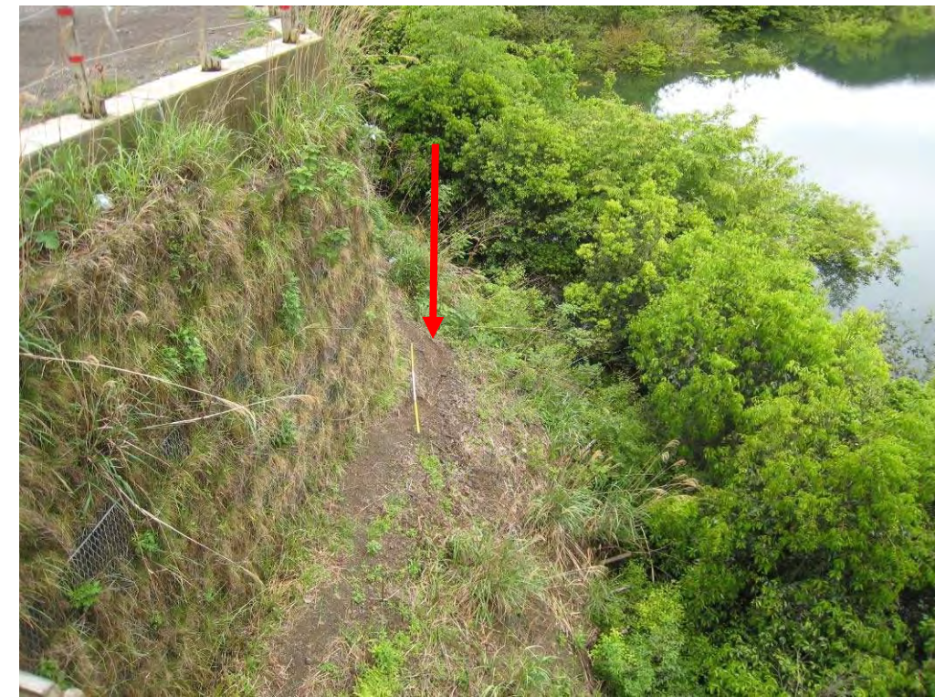
写真 2.2.6 亀裂近景（上流から下流方向を望む）
