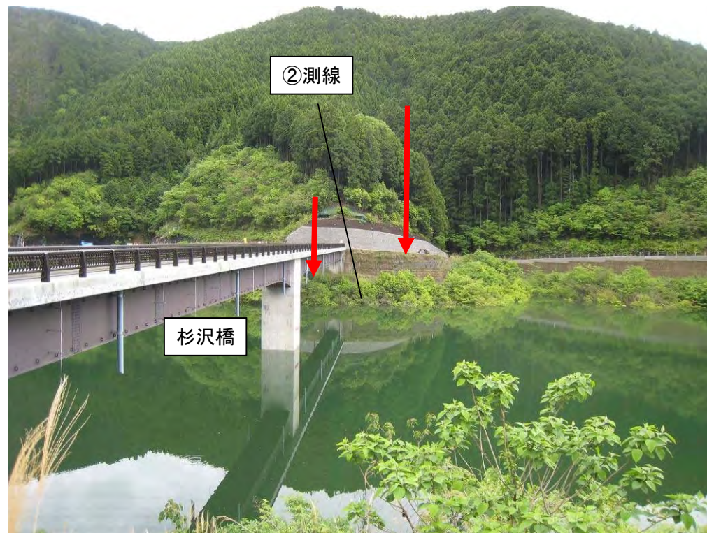
写真 2.2.5 亀裂全景（杉沢右岸林道から望む）
