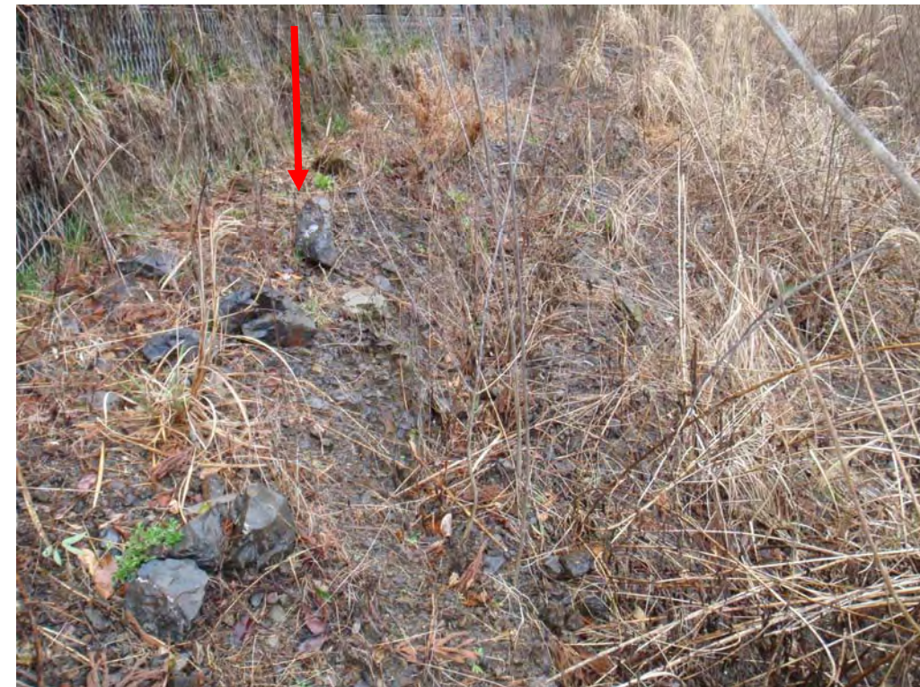
写真 2.2.2 亀裂近景（上流から下流方向を望む）
