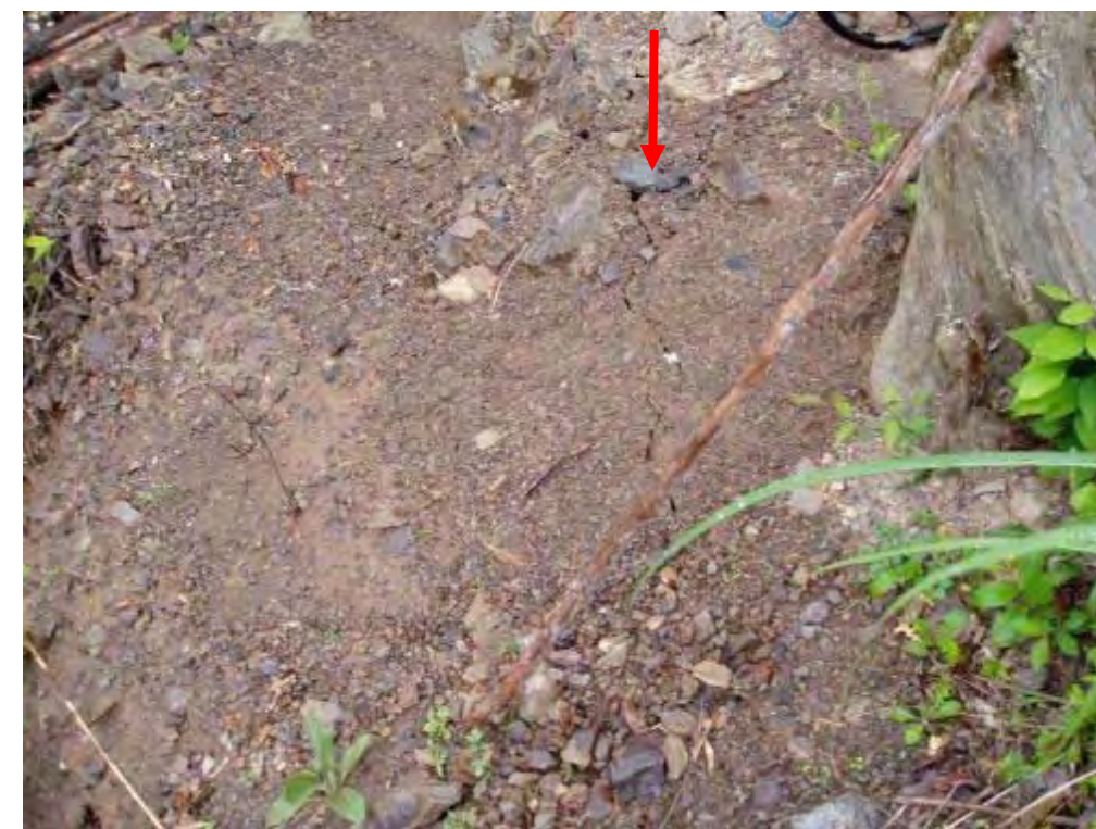
写真 2.2.12 亀裂近景（開口幅は最大で 5mm 程度 5月24日撮影）
