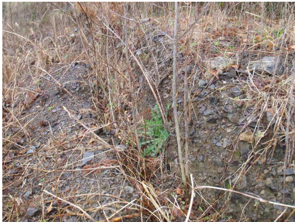
写真 2.2.3 亀裂近景（開口幅は最大で 1m 程度）
