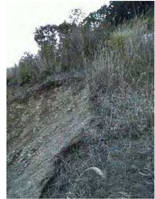
写真 2.2.15 崩壊地の上部の状況。
