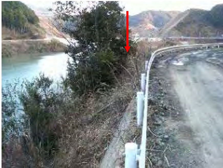
写真 2.2.16 崩壊地上部。基準点候補地点(上流側から望む)
