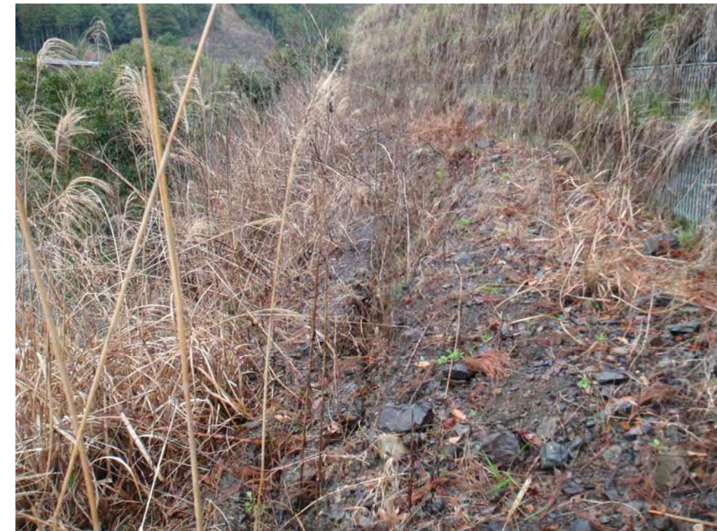
写真 2.2.4 亀裂近景（手前側で開口が収束。補強土壁基礎にはかからない）
