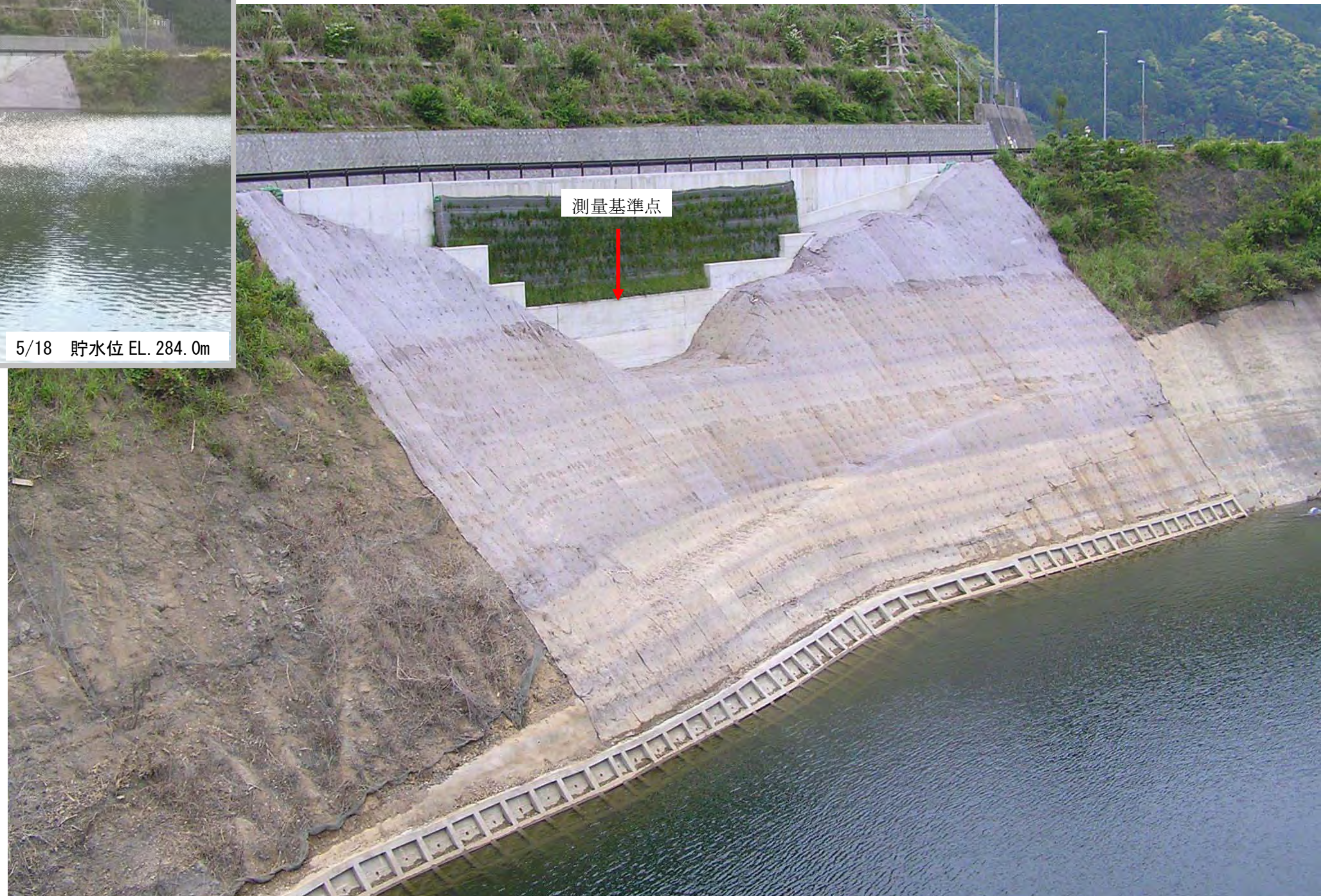
ダムサイト右岸直上流地区(6/3、貯水位 270. 5m)
