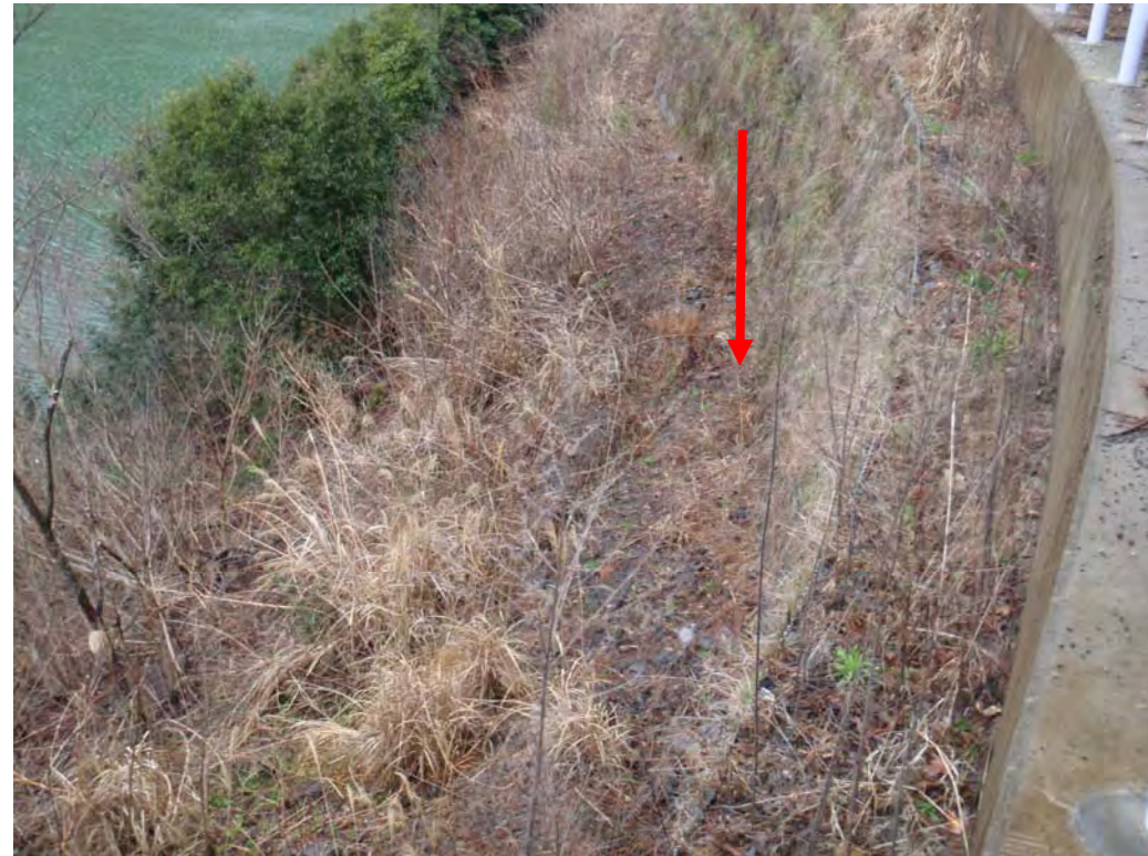
写真 2.2.1 亀裂全景（林道から望む）
