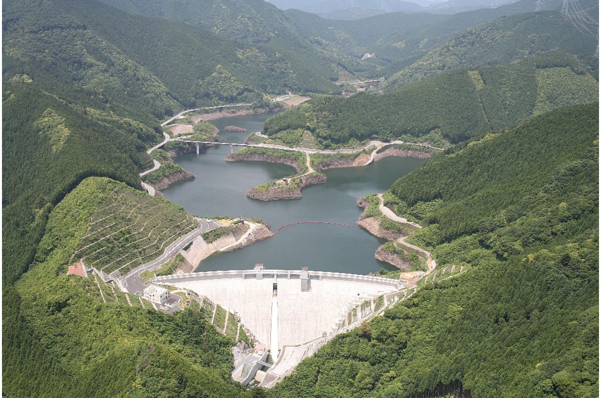
完成した太田川ダム（平成21年6月12日撮影）
