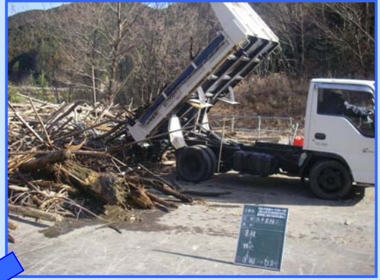
集めた流木を重機で引き上げ集積
