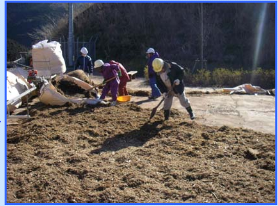
運搬して敷き均し
