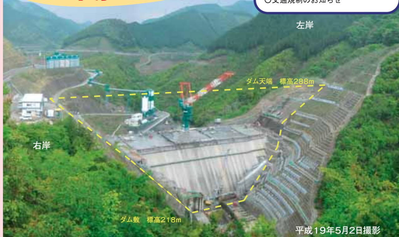
平成19年5月2日現在で、本体コンクリート工事は、完成時の高さ70mのうち約36mまで打ちあがり、コンクリートは全体24万m<sup>3</sup>のうち約13万m<sup>3</sup>を使用しました。
