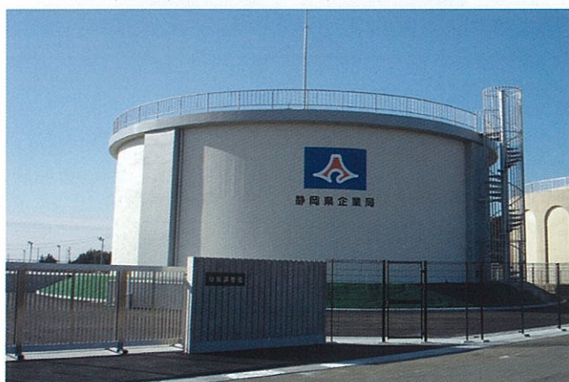
勾坂調整池 平成18年1月完成
