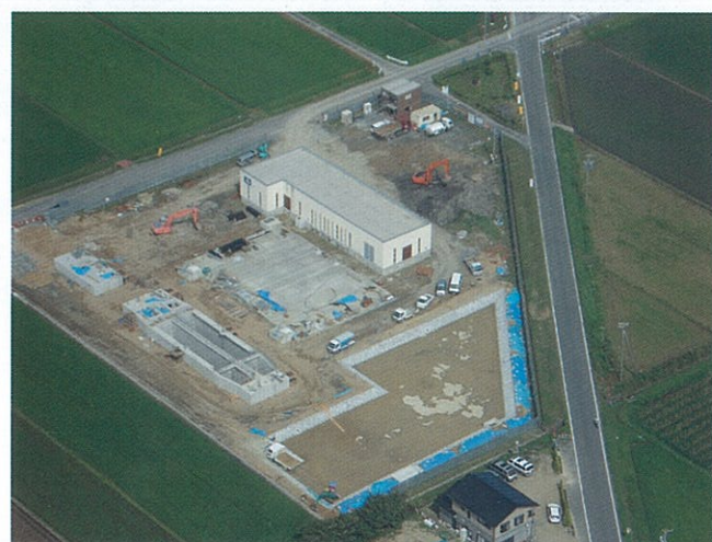
森取水ポンプ場 建設中
