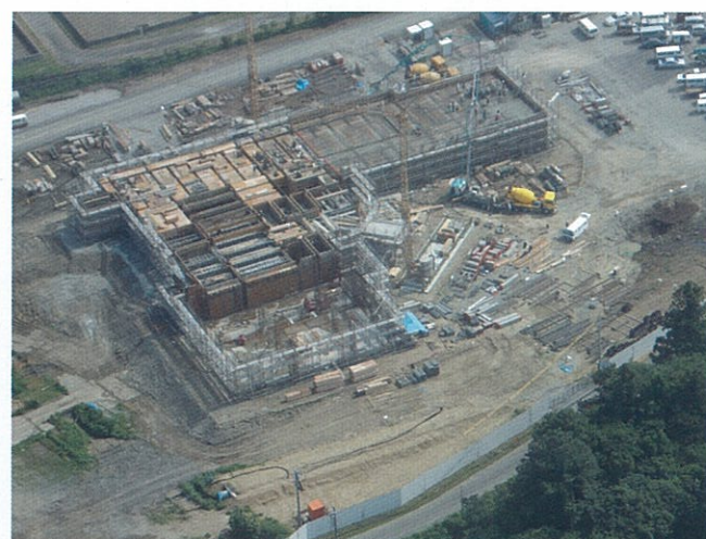
新寺谷浄水場管理本館 建設中
