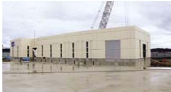
森ポンプ場施工状況
