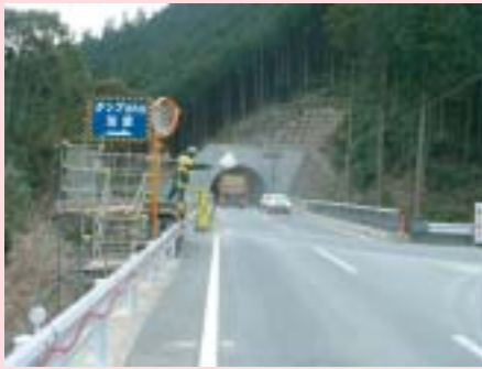
▲工事用道路として、また生活道路として使われています。
