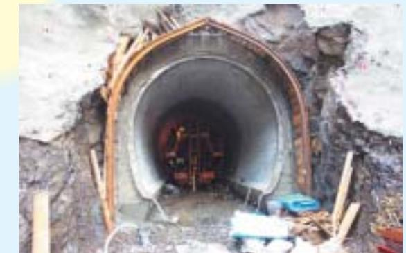
▲このトンネルは年1回程度の洪水を流すことの出来る大きさを確保しています。安全に洪水を流すためコンクリートで補強しています。
